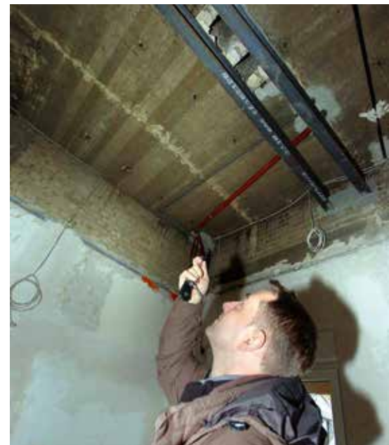
Energieberater Christoph Weiss überprüft den Fortschritt der Arbeiten.
