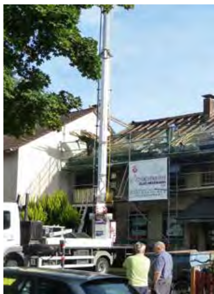
Ein professioneller Dachdecker übernimmt die Demontage des alten Dachstuhls.
