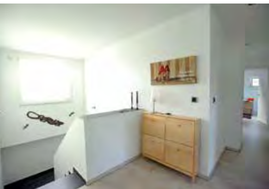
Tolle Lösung: Um einen teuren Deckendurchbruch zu umgehen, wurde ein Teil des Treppenhauses in den Wohnraum integriert.
