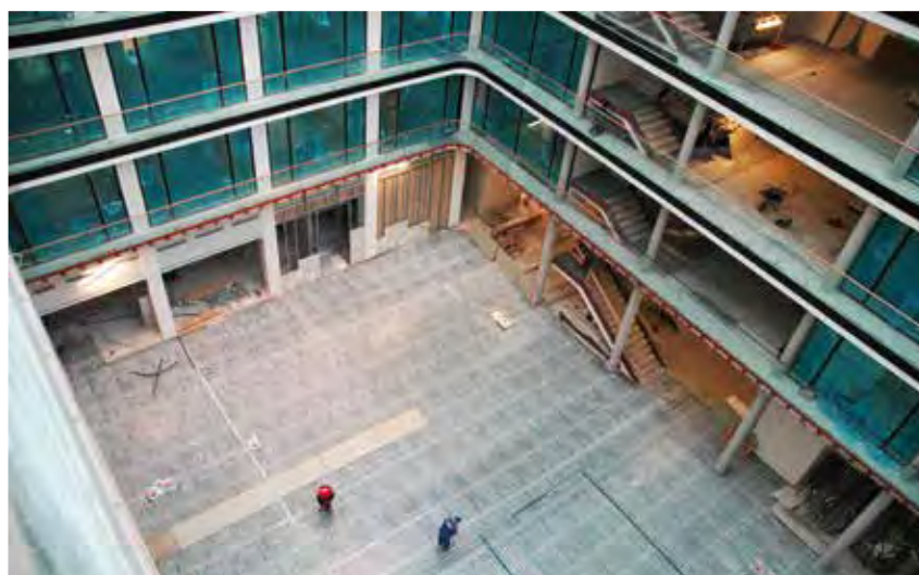
Tausende Meter Rohr wurde allein für die Fußbodenheizung im EG verlegt.
