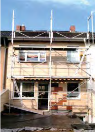
Fassade und Dach wiesen nach 25 Jahren ohne Sanierung einige Mängel auf. 2012 wurden deshalb beide ausgebessert.
